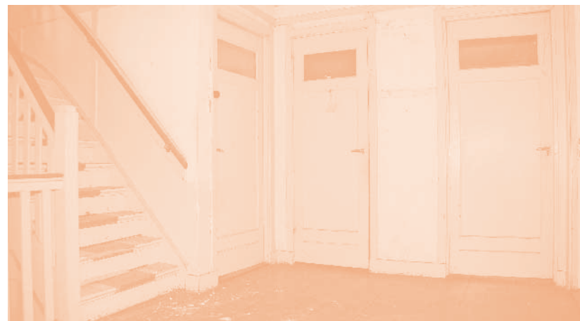
De hal op de verdieping met links de trap naar de vloering.
